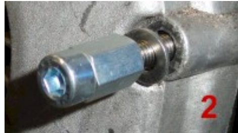
Montieren des Sechskantes auf den Gewindestangen
