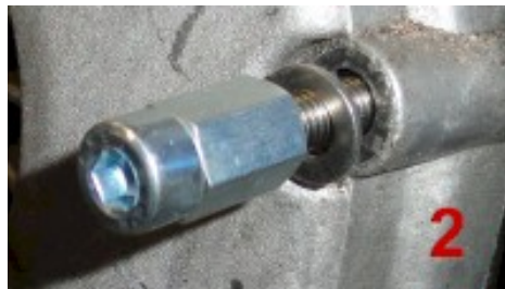
Montieren des Sechskantes auf den Gewindestangen
