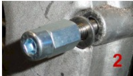
Montieren des Sechskantes auf den Gewindestangen
