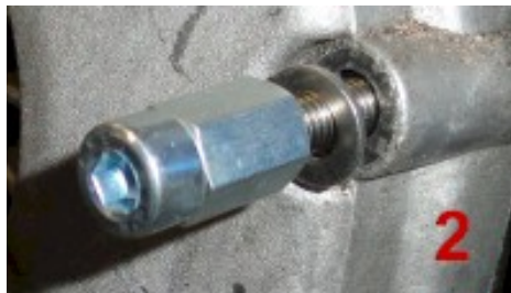
Montieren des Sechskantes auf den Gewindestangen
