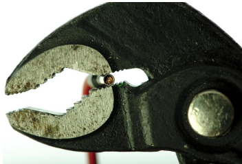
Crimpen mit einer Wasserpumpenzange.
