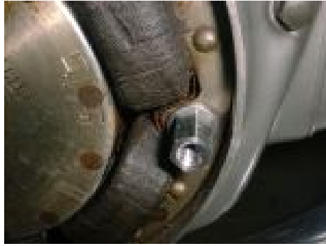
Abbildung 2 Montage der Abstandsbolzen.
