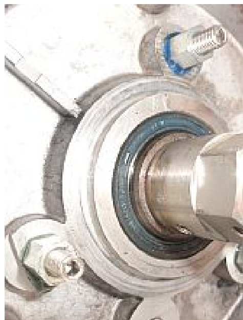
Abbildung 2 Abstandshalter werden montiert.
