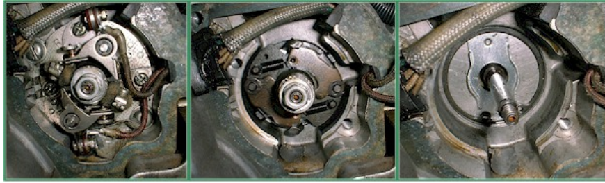
Abbildung 2 Demontage der alten Zündungskomponenten.
