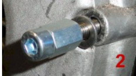
Montieren des Sechskantes auf den Gewindestangen
