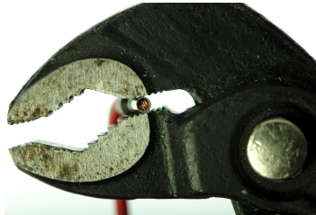
Crimpen mit einer Wasserpumpenzange.
